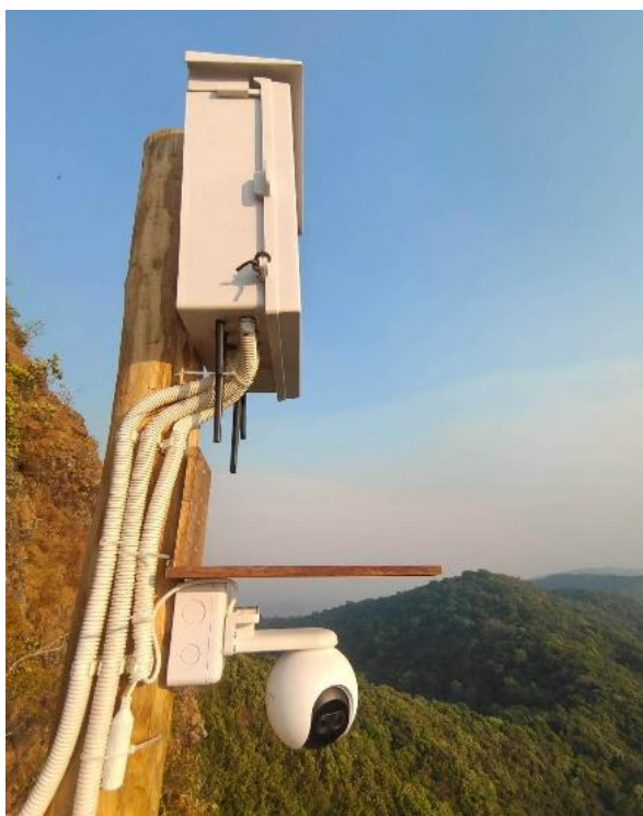
ภาพที่ 9: เซนเซอร์เฝ้าระวังไฟป่า บ้านดอยช้างป่าแป๋ (ที่มาภาพ: นายบัญชา มุแอ)
